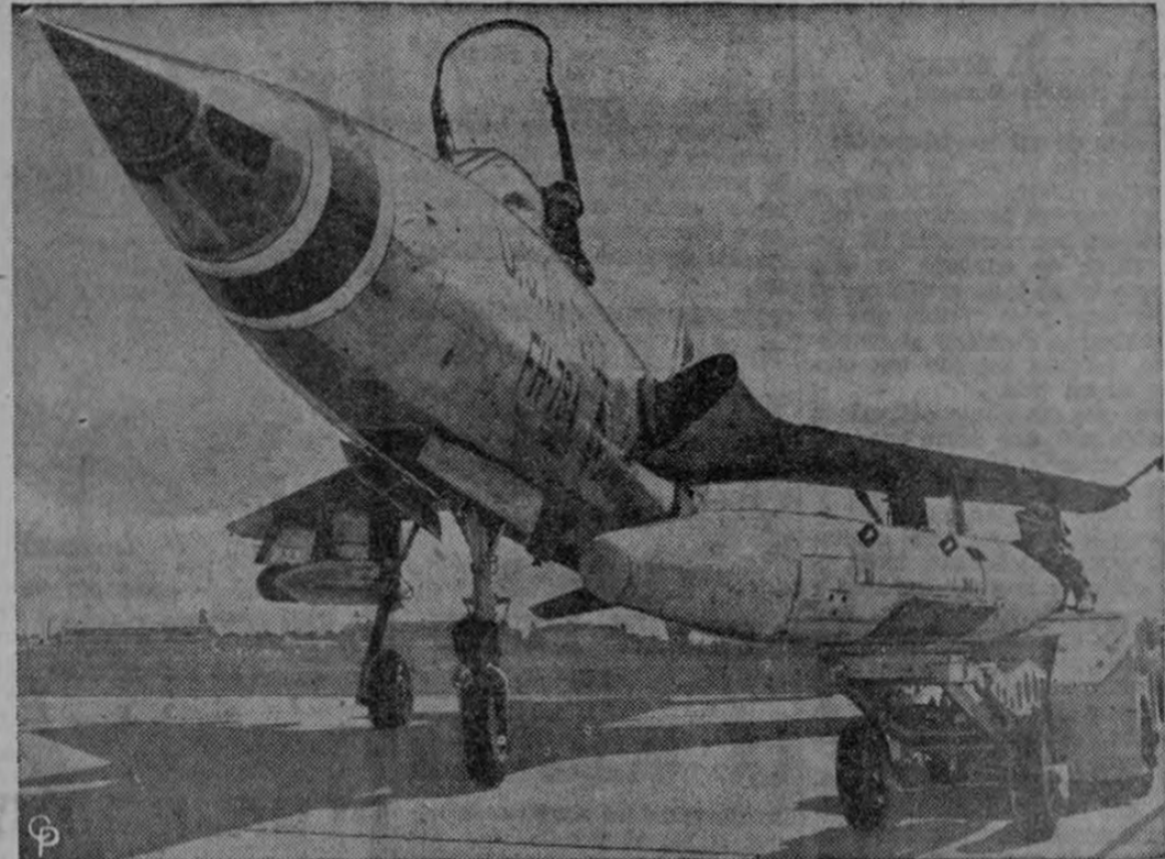
NUEVO LANZADOR DE BOMBAS.—Un miembro de la tripulación de tierra conduce un nuevo lanzador de bombas que puede lanzar bombas nucleares desde un caza bombardero que viaje a una velocidad doble del sonido, para instalarla en la base aérea de Eglin en Florida. El lanzador de bombas de la Republic es necesario debido a la tremenda presión de aire que pasa alrededor de un avión que viaje a tal velocidad. El nuevo aparato tiene una presión de 30.000 libras o más
